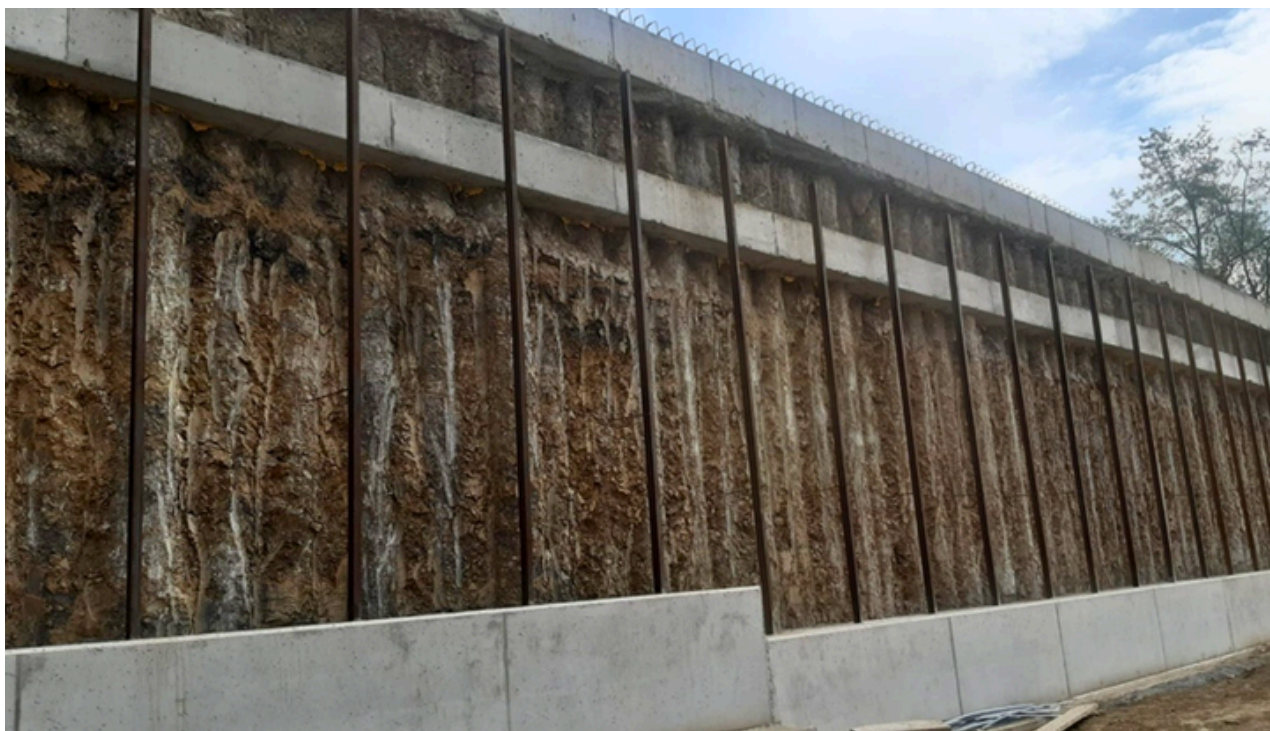
Zdj. nr 10 – Montaż stelaża do oblicowania konstrukcji oporowej (konstrukcja KO_K2)
