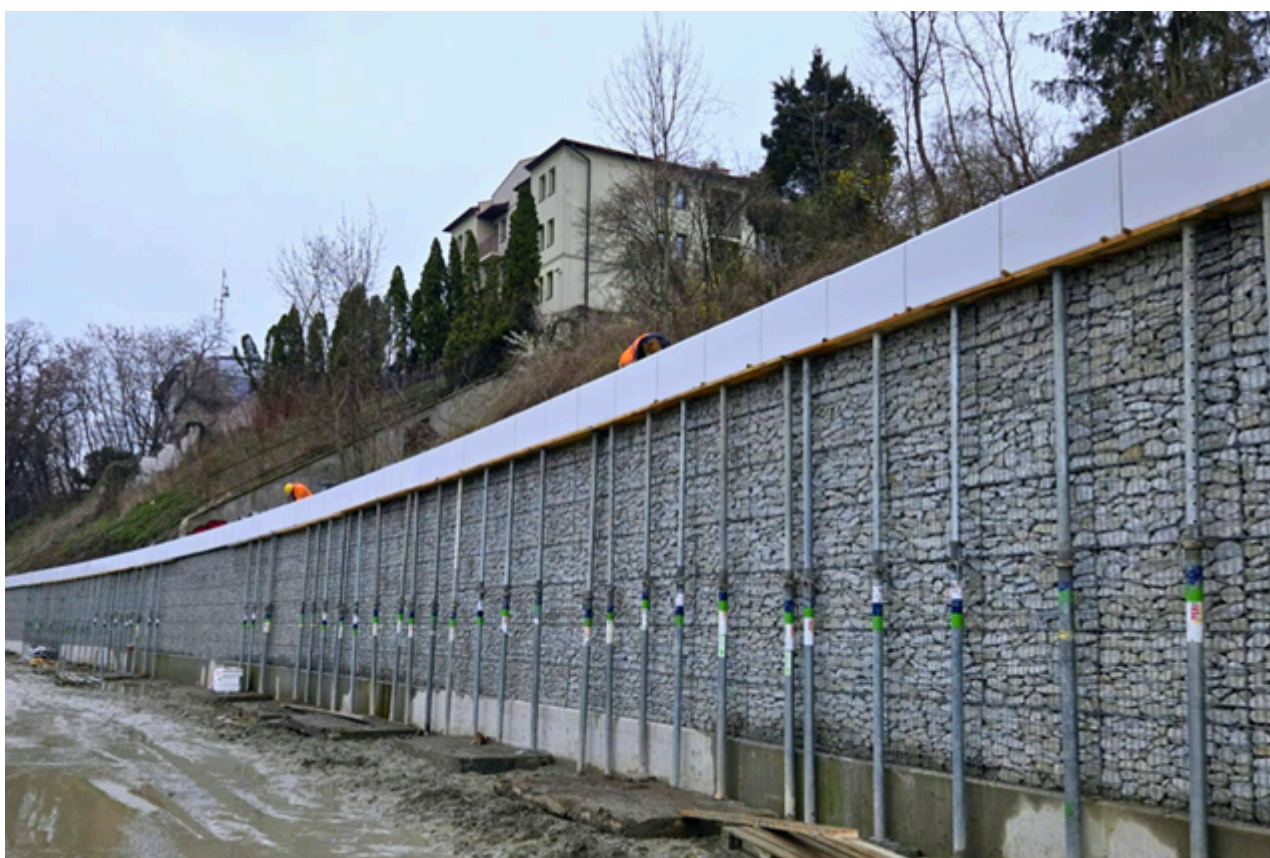
Zdj. nr 11 – Montaż deski gzymsowej okrywającej oblicowanie z koszy gabionowych (konstrukcja KO_K4)
