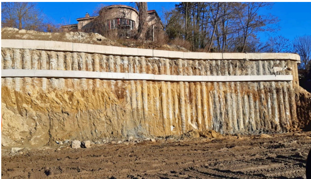
Zdj. nr 7 – Kotwiona konstrukcja oporowa w fazie największego odstąpienia (konstrukcja KO_K4)
