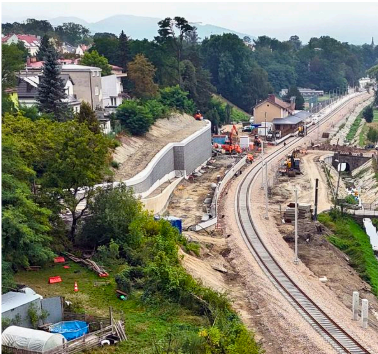
Zdj. nr 12 – Widok ukończonej konstrukcji oporowej (konstrukcja KO_K4)
