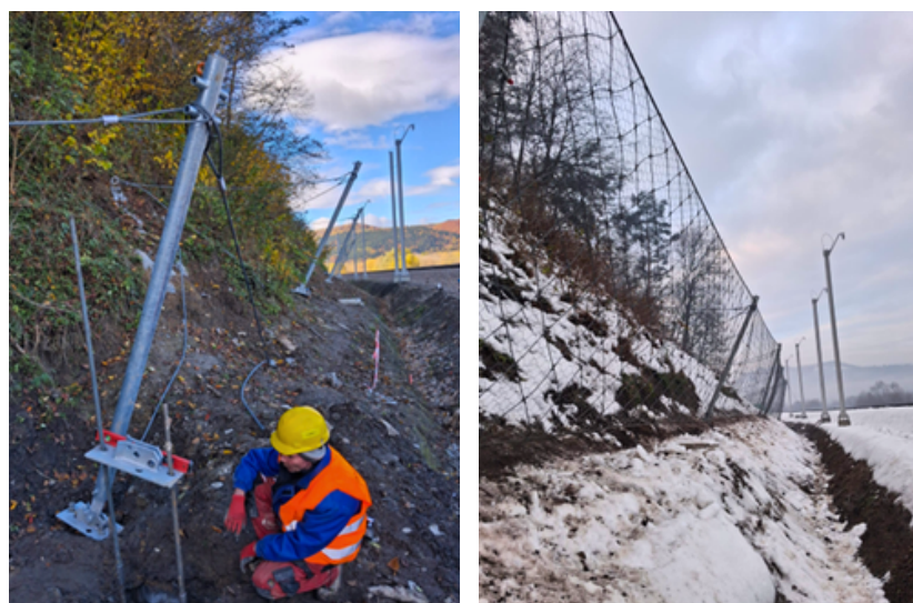
Zdj. nr 9 – Montaż bariery typu RB750 (obszar OS9_P2)
