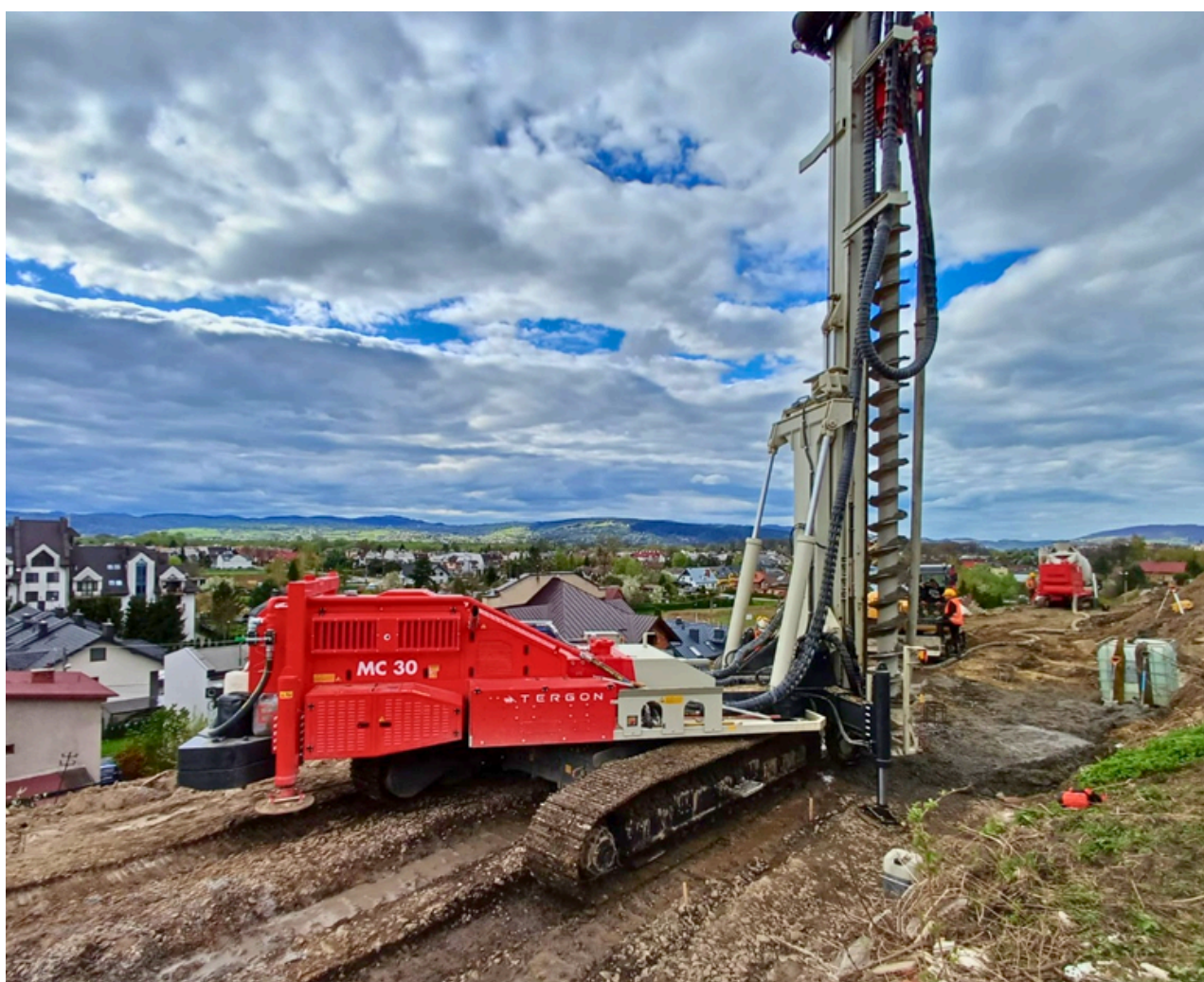
Zdj. nr 2 – Praca lekkiej jednostki wiertniczej Comacchio MC 30 w ramach wykonywania konstrukcji KO_K8.
