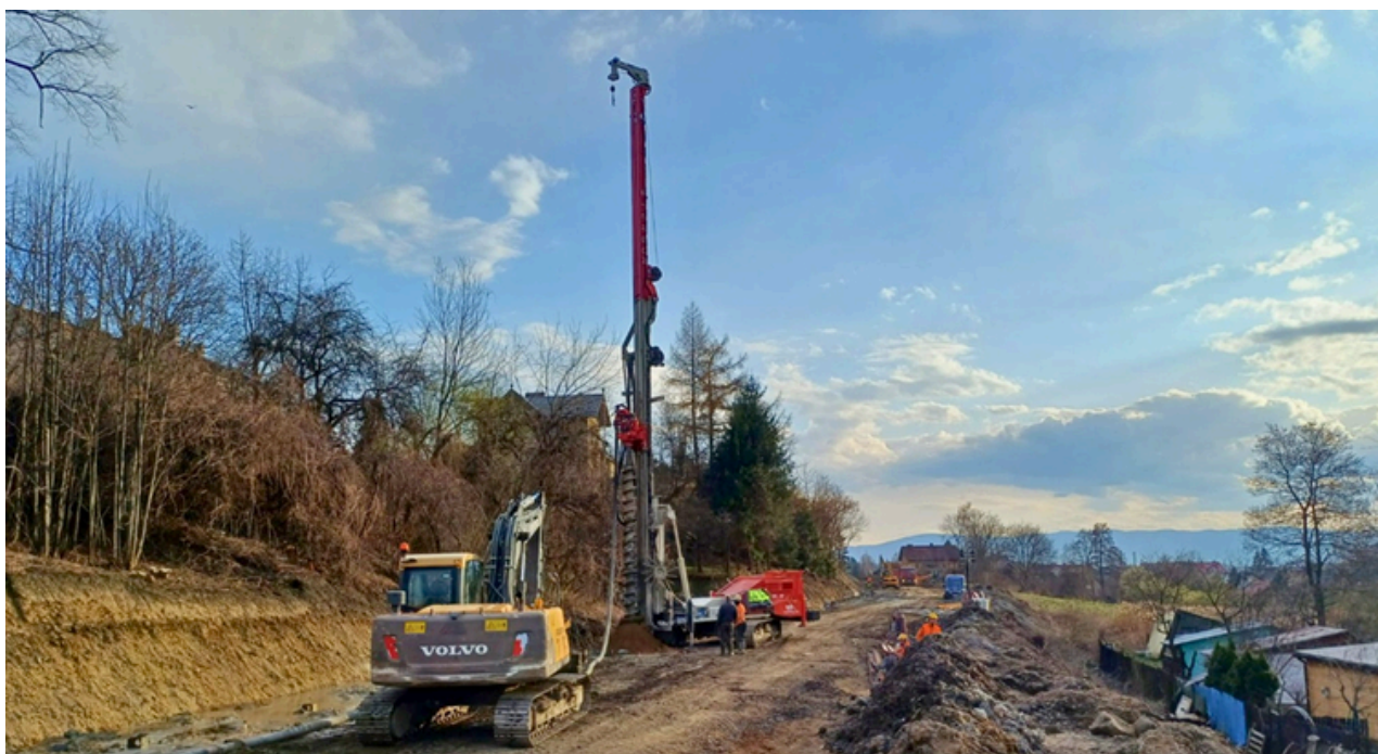
Zdj. nr 3 – Zestaw sprzętowy do wiercenia pali Comacchio MC 30 (konstrukcja OS4-7_P1)
