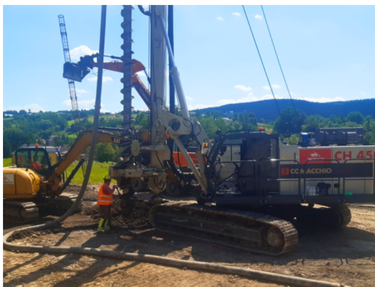
Zdj. nr 4 – Zestaw sprzętowy do wiercenia pali Comacchio CH 450 (konstrukcja KO_K2)
