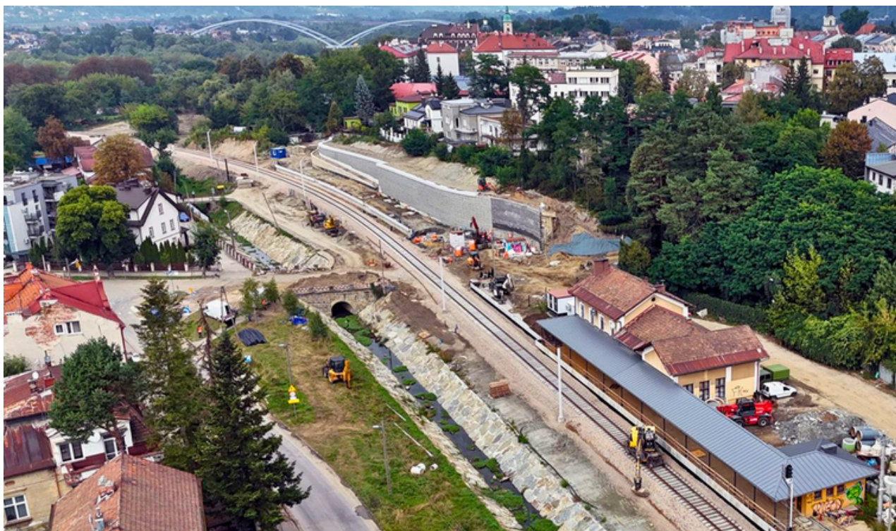
Zdj. nr 1 – Widok przykładowej konstrukcji oporowej (KO_K4) stanowiącej zabezpieczenie podcięcia skarpy w Nowym Sączu.
