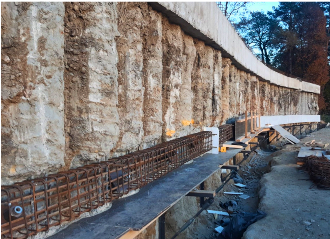
Zdj. nr 6 – Pośredni poziom zakotwienia konstrukcji oporowej (konstrukcja KO_K4)
