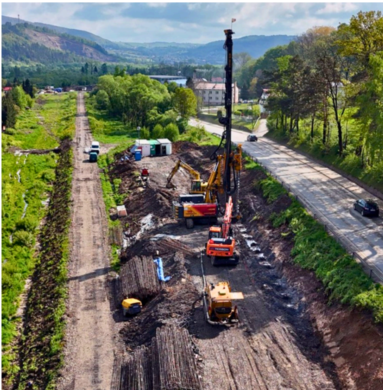
Zdj. nr 5 – Zestaw sprzętowy do wiercenia pali RTG RG 22S (konstrukcja KO_K3)
