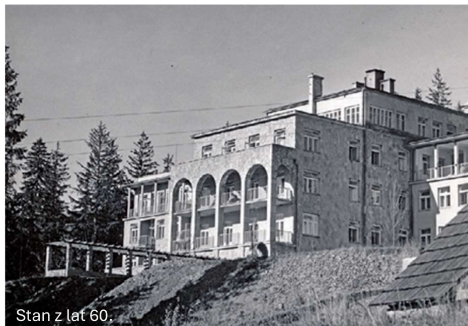
Budowa willi 1937r.-1938r.
