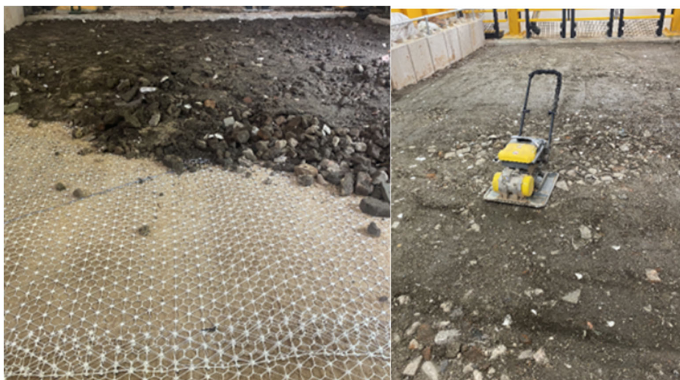
Fot. 2 i 3. Widok kruszywa antropogenicznego zagęszczanego na georuszcie tworzącego platformę roboczą
