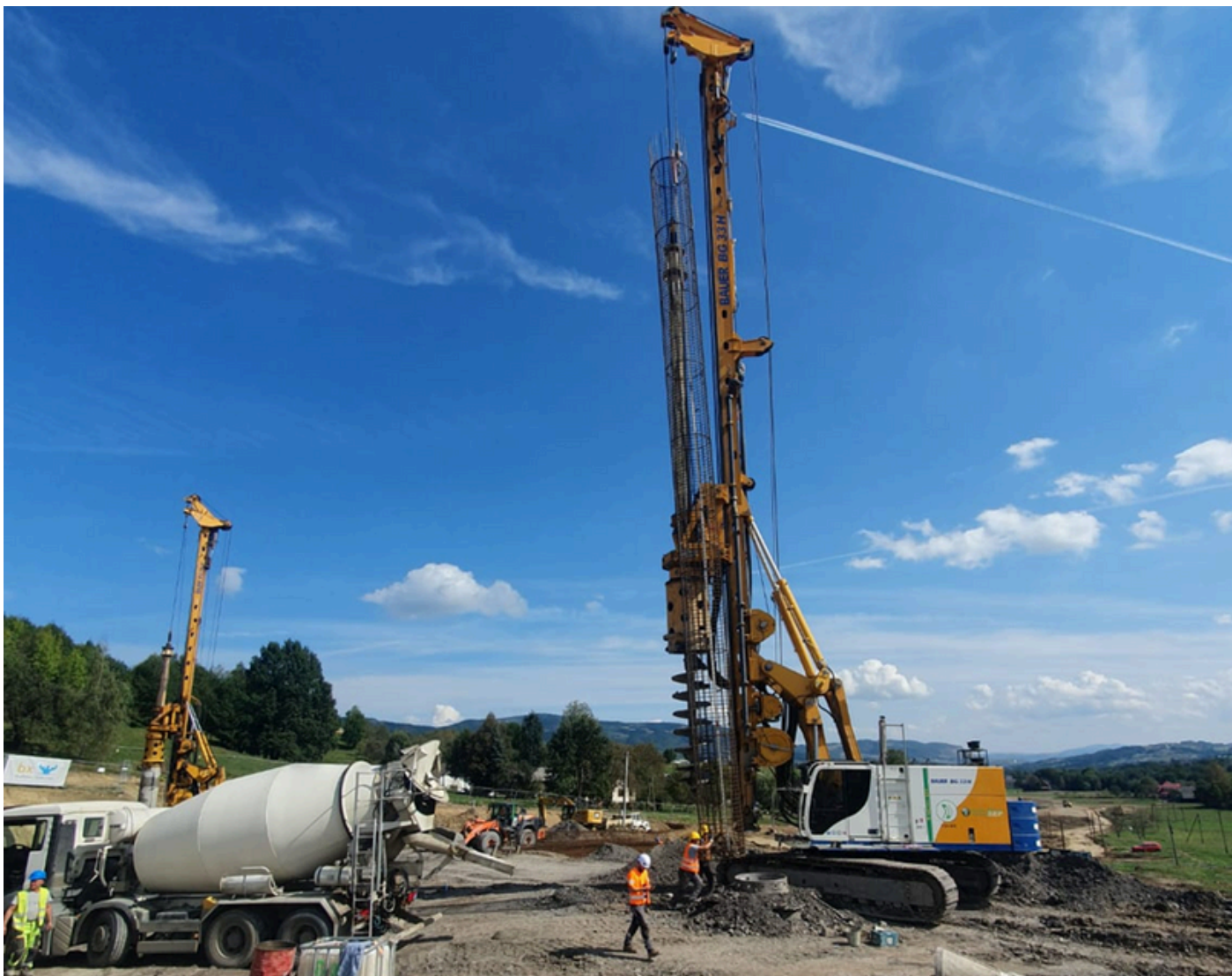
Zdj. nr 3 – Zdjęcie równoległej pracy dwóch palownic na portalu wschodnim
