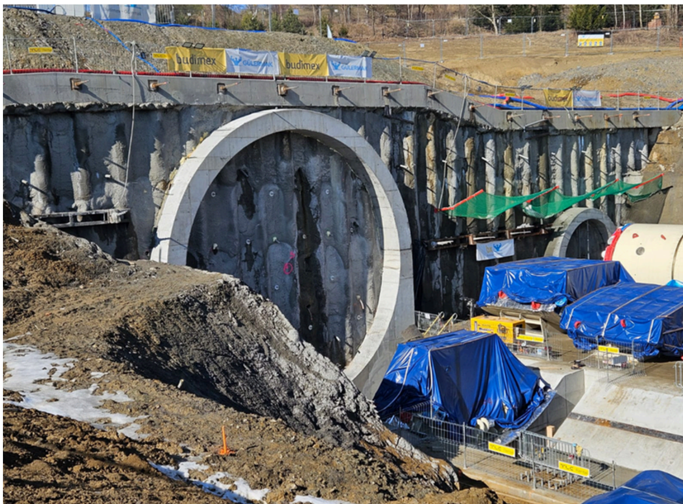
Zdj. nr 8 – Zdjęcia przygotowanego portalu wschodniego do wprowadzenia maszyn TBM
