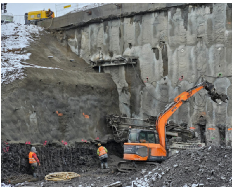
Zdj. nr 7 – Praca zestawu do zabezpieczania skarp przyległych
