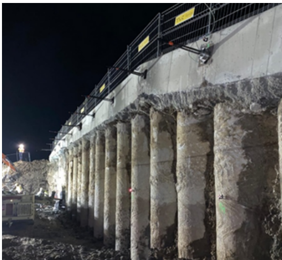
Zdj. nr 4 – Widok oczepu żelbetowego
