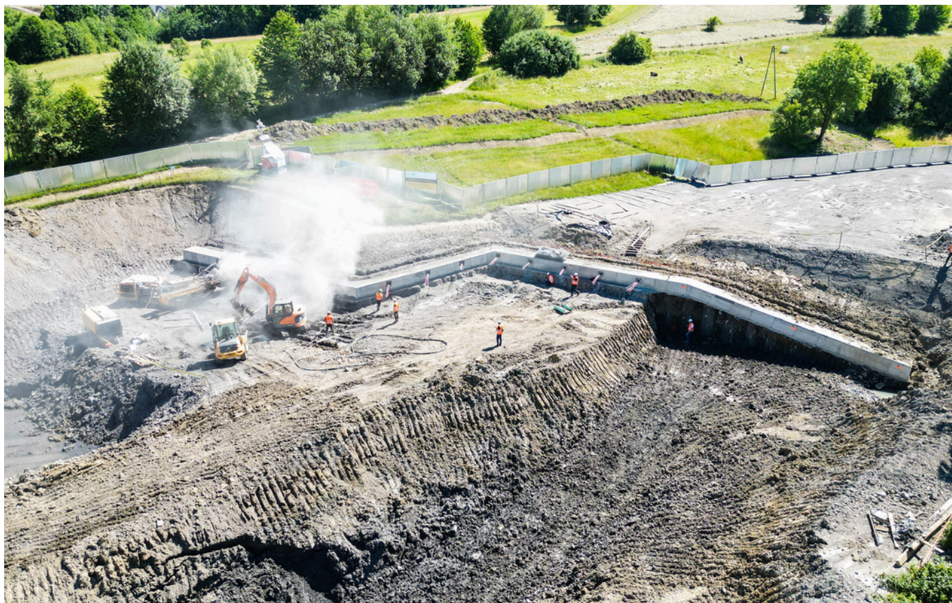
Zdj. nr 5 – Praca zestawu do wiercenia kotew gruntowych na portalu zachodnim
