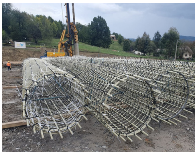
Zdj. nr 2 – Zdjęcia sprefabrykowanych koszy z prętów GFRP średnicy 25mm
