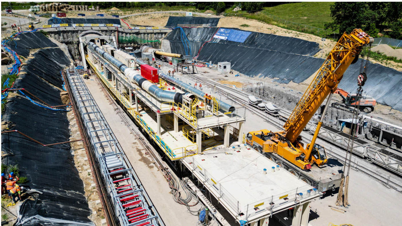
Zdj. nr 1 – Zdjęcia gotowego portalu wschodniego wraz z pracującymi maszynami TBM
