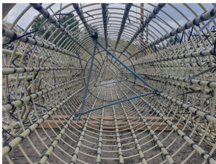
Zdj. nr 2 – Zdjęcia sprefabrykowanych koszy z prętów GFRP średnicy 25mm
