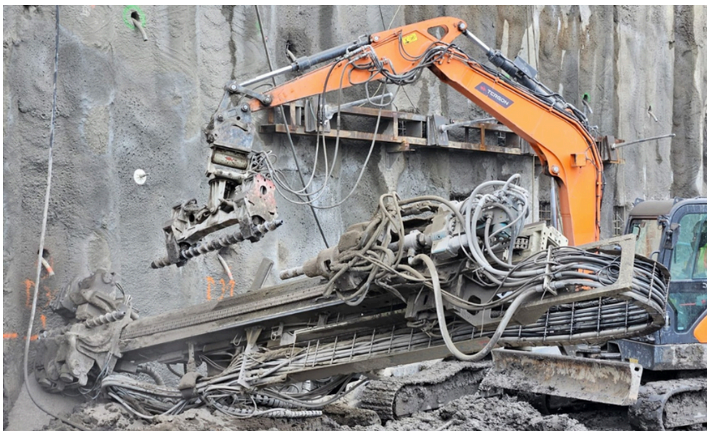
Zdj. nr 6 – Praca zestawu do wiercenia gwoździ gruntowych GFRP oraz drenów wgłębnych w czole ściany portalu wschodniego
