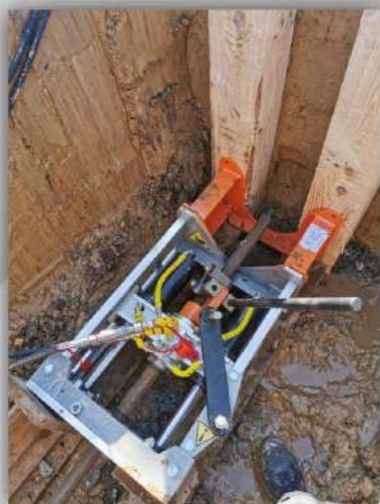
Maszyna UM-32 w wykopie
