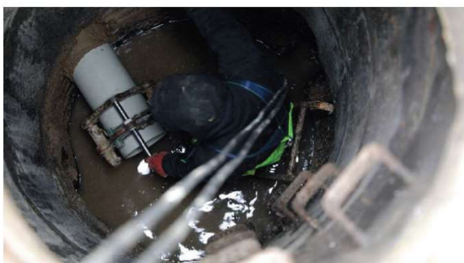
Budowa instalacji kanalizacyjnej z Rur Modułowych w obszarze studni
