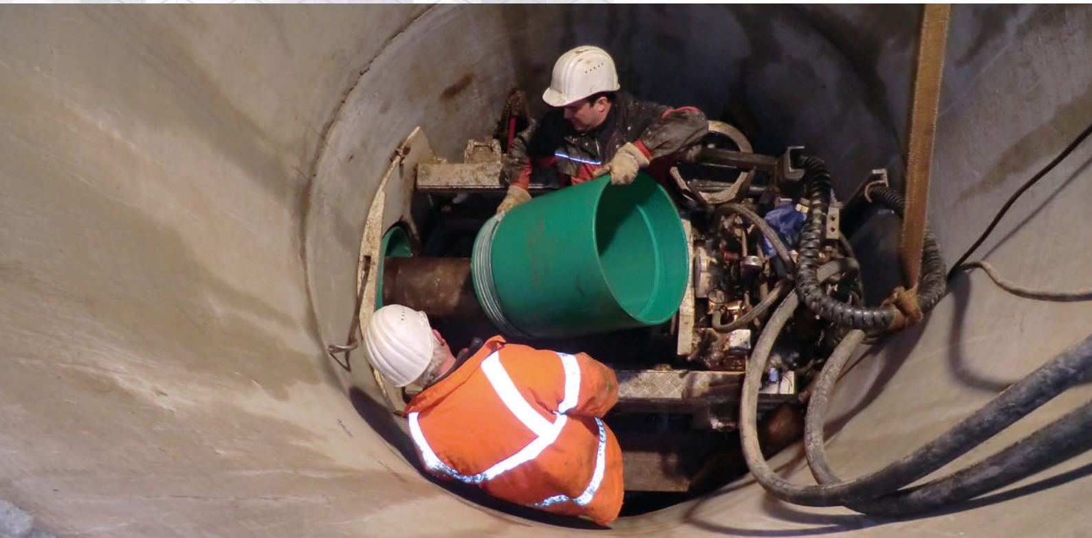
Przewiert pilotażowy DN/ OD 560 ze studni startowej DN 2000
