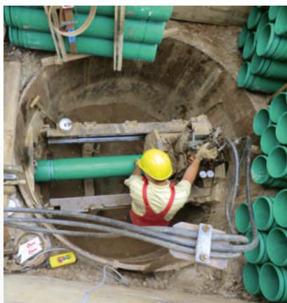
montaż za pomocą przewiertu pilotażowego
