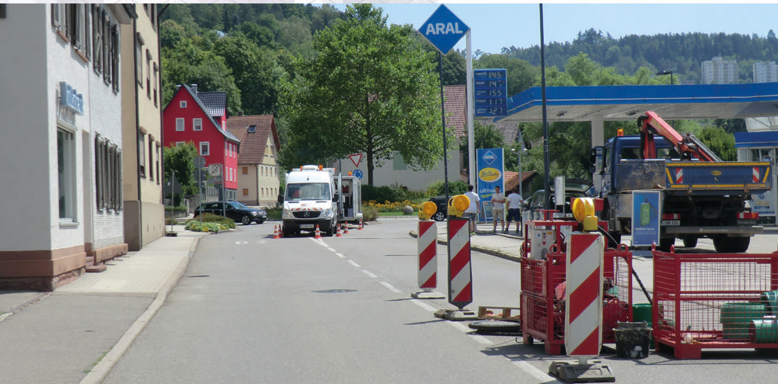
renowacja rurociągu ze studni do studni
