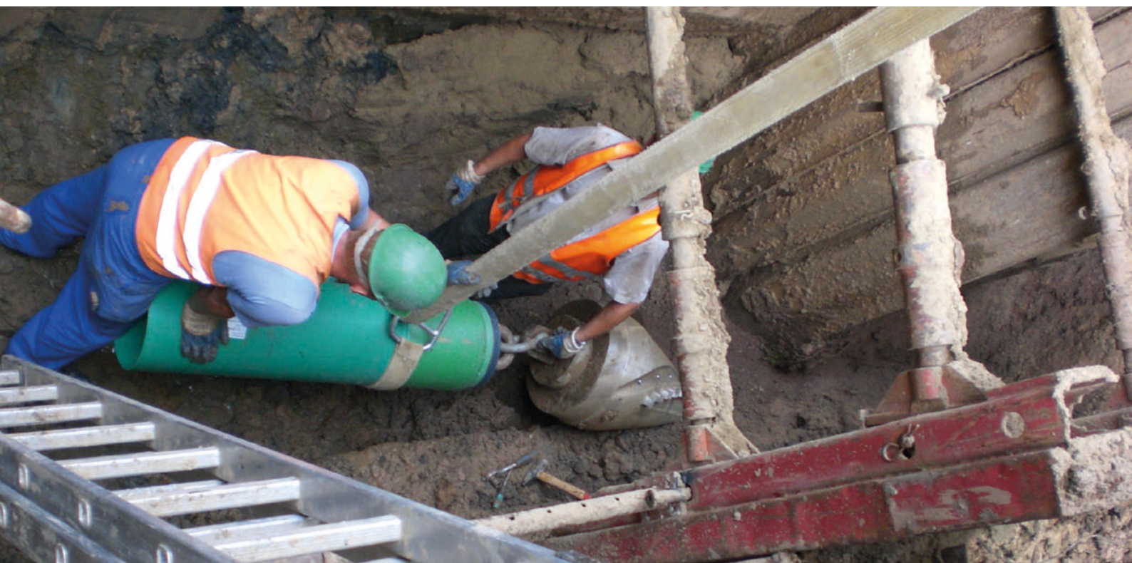
wciąganie pojedynczej rury przewiert horizontalny
