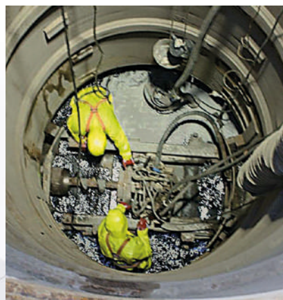
bezwykopowy montaż rur przewiertowych
