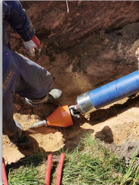
Przecisk bezpłuczkowy sterowany 52m z wykopu prostokątnego (PE160, Wodociągi Suszec)
