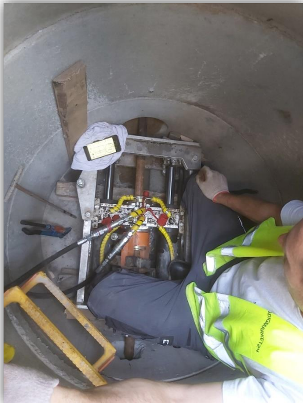
Rysunek 4. Maszyna w studni startowej Dn1000
