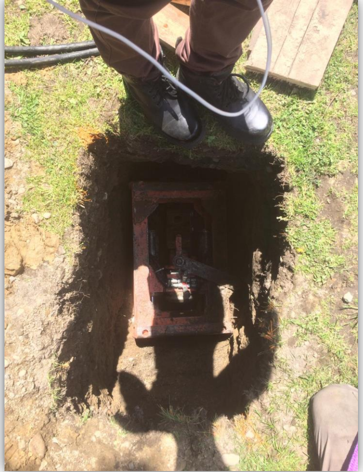
Przecisk z mini wykopu 1m x0,5m. Totalny rekord minimalizacji wykopu. Rura instalowana PE 110 mm -Oświęcim
