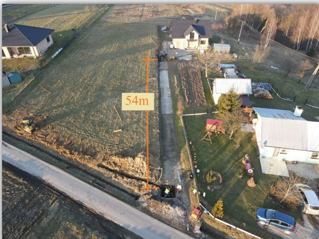
Rysunek 3. Wciąganie rury 54m PE90, Gazociąg Tarnów, pod płytami betonowymi w silnie nawodnionym terenie
