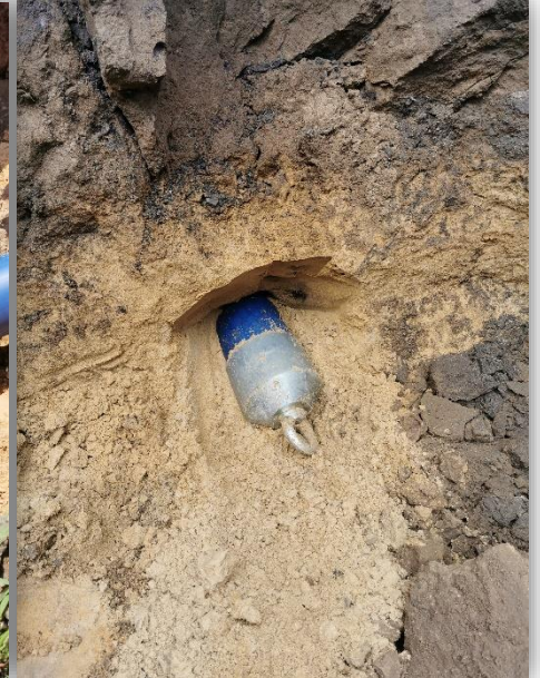
Przecisk bezpłuczkowy sterowany 52m z wykopu prostokątnego (PE160, Wodociągi Suszec)
