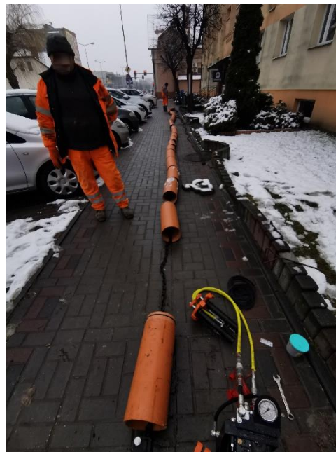
Relining studzienny Wciąganie krótkich modułów rurowych DN200 (Wodociągi Tarnobrzeg)
