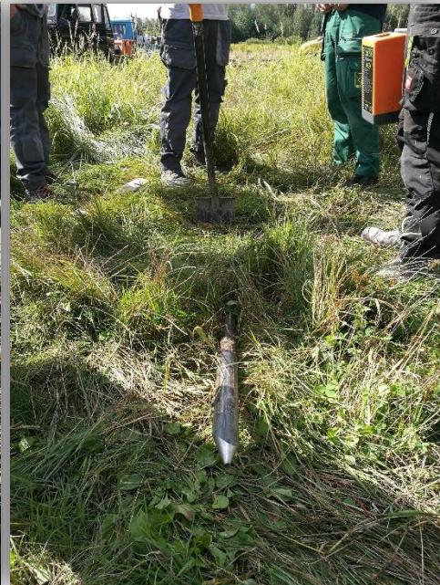
Przecisk z mini wykopu 1m x0,5m. Totalny rekord minimalizacji wykopu. Rura instalowana PE 110 mm -Oświęcim
