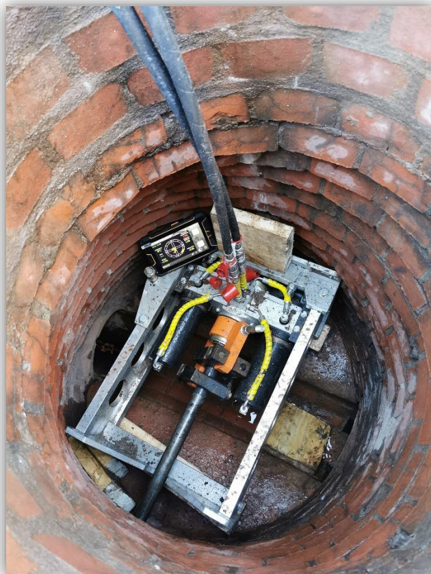
Rysunek 2. Praca ze studni DN900, bez opory półokrągłej
