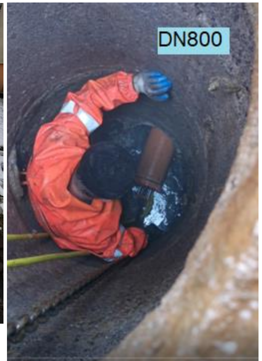
Relining studzienny Wciąganie krótkich modułów rurowych DN200 (Wodociągi Tarnobrzeg)
