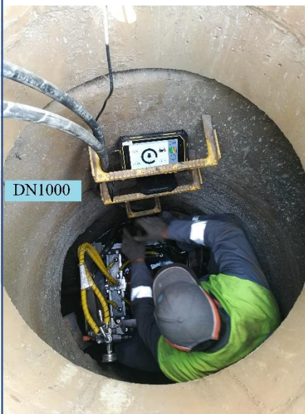
Relining studzienny Wciąganie krótkich modułów rurowych DN200 (Wodociągi Tarnobrzeg)
