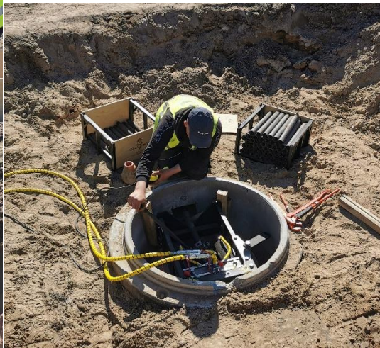
Zdjęcie 6 Wykonanie kanalizacji grawitacyjnej PVC 200, 12m
