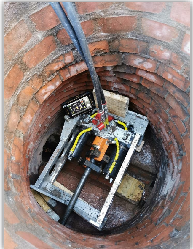
Zdjęcie 1. Praca ze studni DN900,
