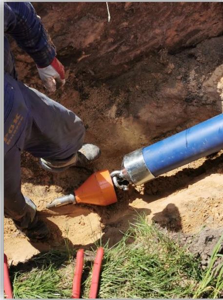
Przecisk bezpłuczkowy sterowany, odcinek 52m z wykopu prostokątnego (PE160, Wodociąg Suszec, grunty zwarte piaszkowe)
