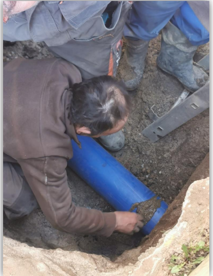
Kraking statyczny, DN160, Żagań. Zamiana istniejących rur PVC160 na PE160
