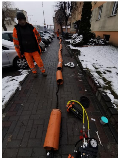
Relining studzienny Wciąganie krótkich modułów rurowych DN200 (Wodociąg Tarnobrzeg, odcinek ~30m)
