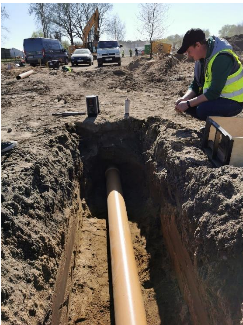
Zdjęcie 6 Wykonanie kanalizacji grawitacyjnej PVC 200, 12m
