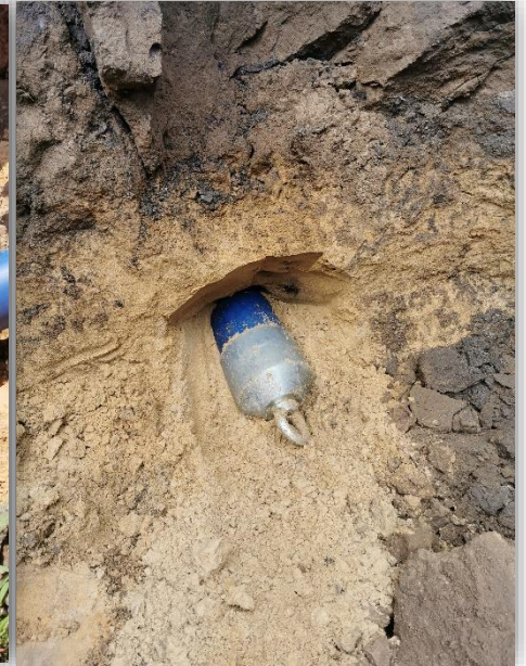
Przecisk bezpłuczkowy sterowany, odcinek 52m z wykopu prostokątnego (PE160, Wodociąg Suszec, grunty zwarte piaszkowe)
