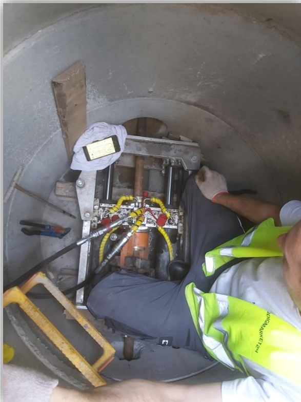
Rysunek 5. Maszyna w studni startowej Dn1000
