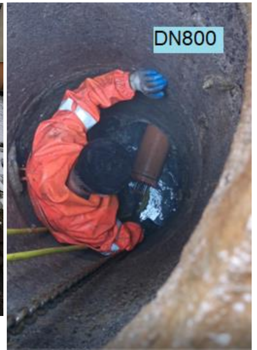
Relining studzienny Wciąganie krótkich modułów rurowych DN200 (Wodociąg Tarnobrzeg, odcinek ~30m)
