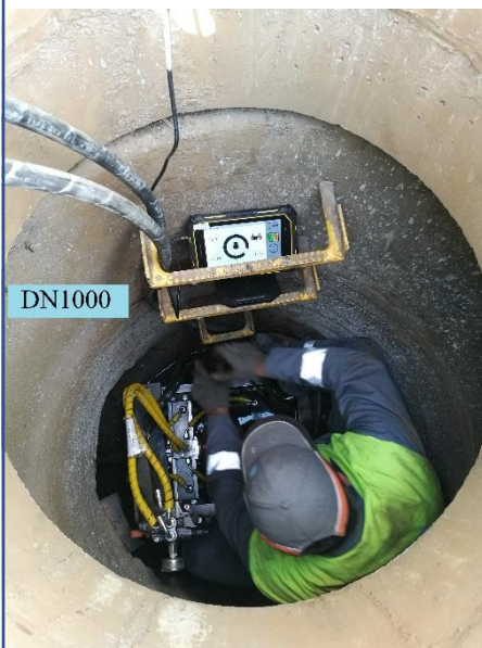
Relining studzienny Wciąganie krótkich modułów rurowych DN200 (Wodociąg Tarnobrzeg, odcinek ~30m)
