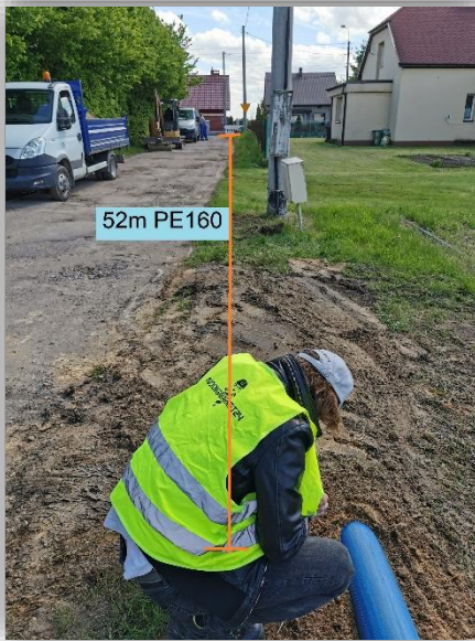
Przecisk bezpłuczkowy sterowany, odcinek 52m z wykopu prostokątnego (PE160, Wodociąg Suszec, grunty zwarte piaszkowe)
